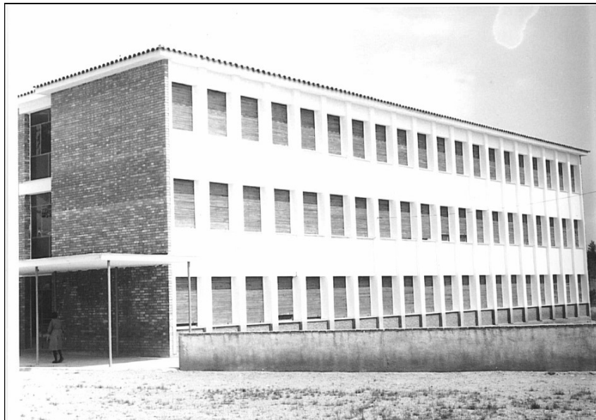
Tercer pavelló amb tres pisos en previsió del creixement de la població.
