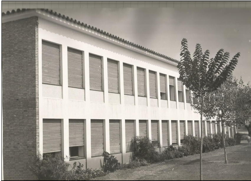
Segon pavelló amb dos pisos
